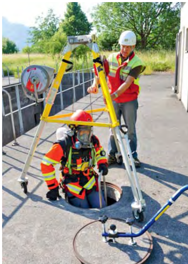
Fig. 3 L'operaio che entra in un pozzo viene sorvegliato direttamente da un'altra persona.
