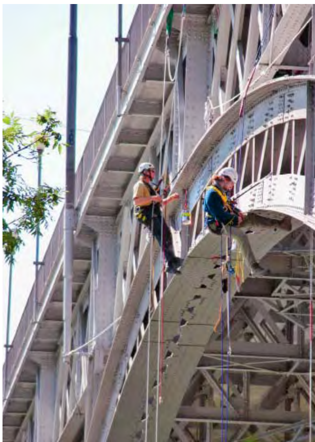
Fig. 2 Lavori in sospensione a corde portanti
